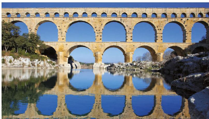
Le pont du Gard, en France : un pont en pierre
